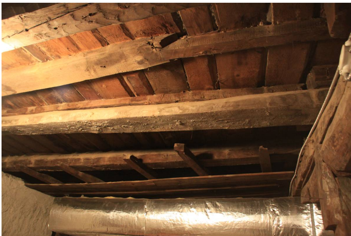
Ε.09.09. Ξύλινος σκελετός δαπέδου γυναικωνίτη
