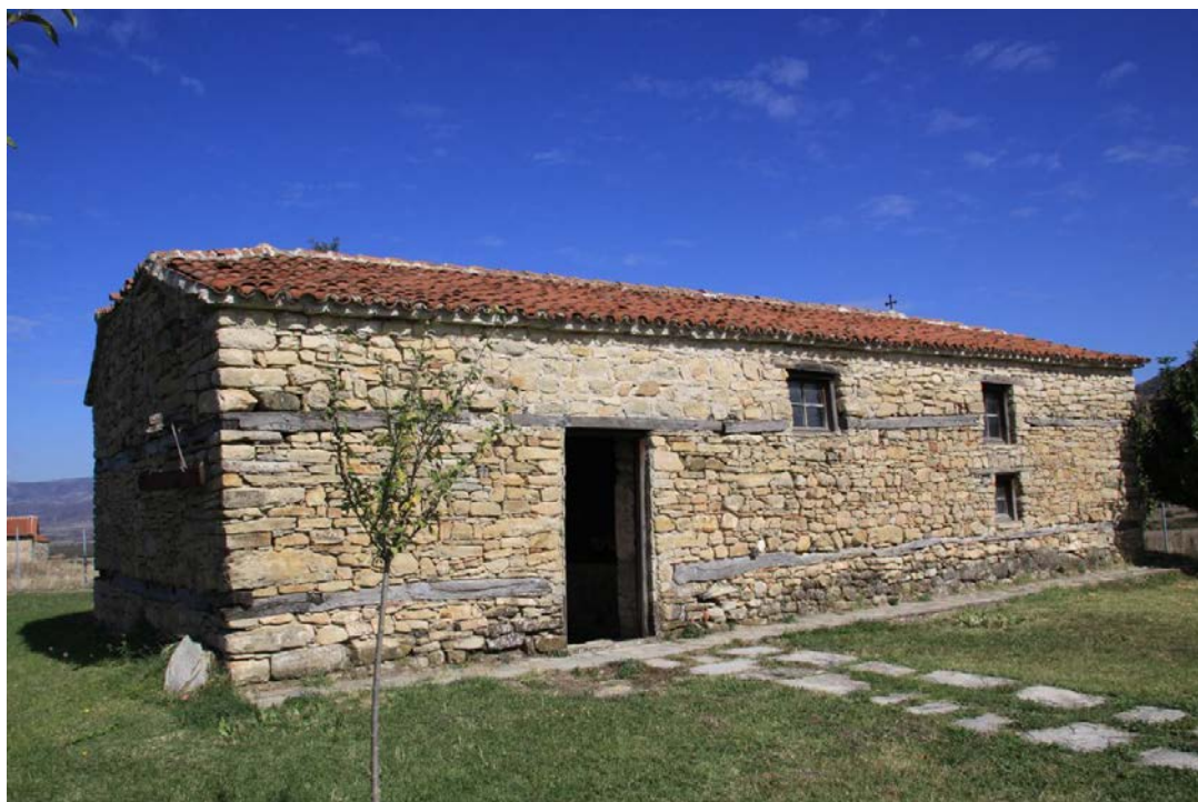
Ε.08.07. Νότια τοιχοποιία
