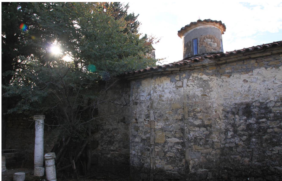
Ε.01.07. Εφαρμογή τσιμεντοειδούς επιχρίσματος στον τρούλο , απόκλιση τρούλου από την κατακόρυφο
