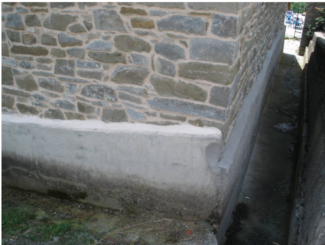
Ε.15.04. Διάνοιξη αύλακα για την απορροή των υδάτων
