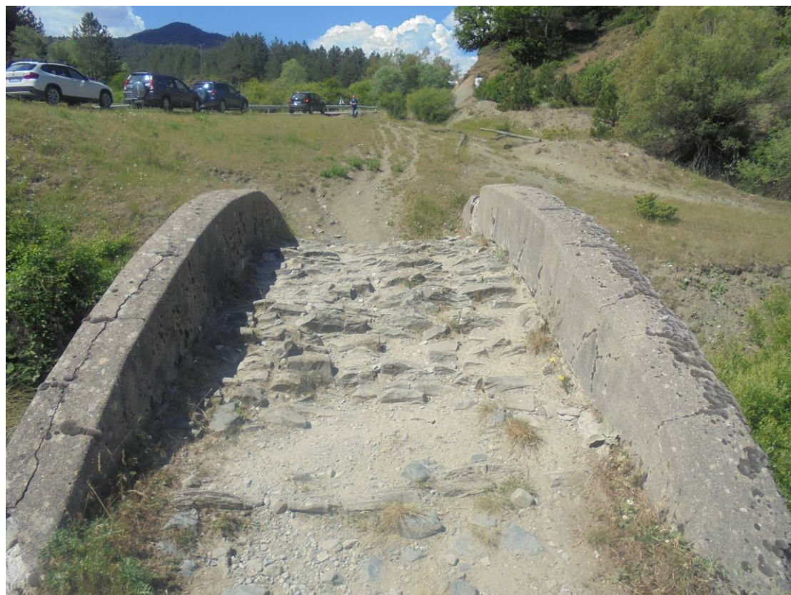
Γ.07.07. Κατάστρωμα γεφυριού
