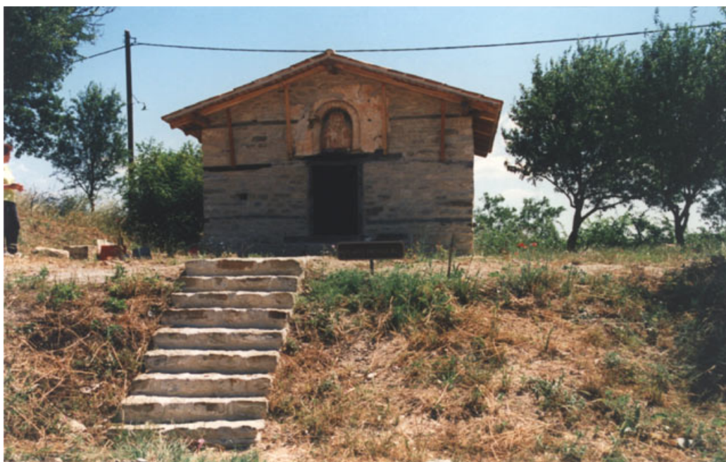
Ε.04.00. Εξωτερική όψη του ναού
