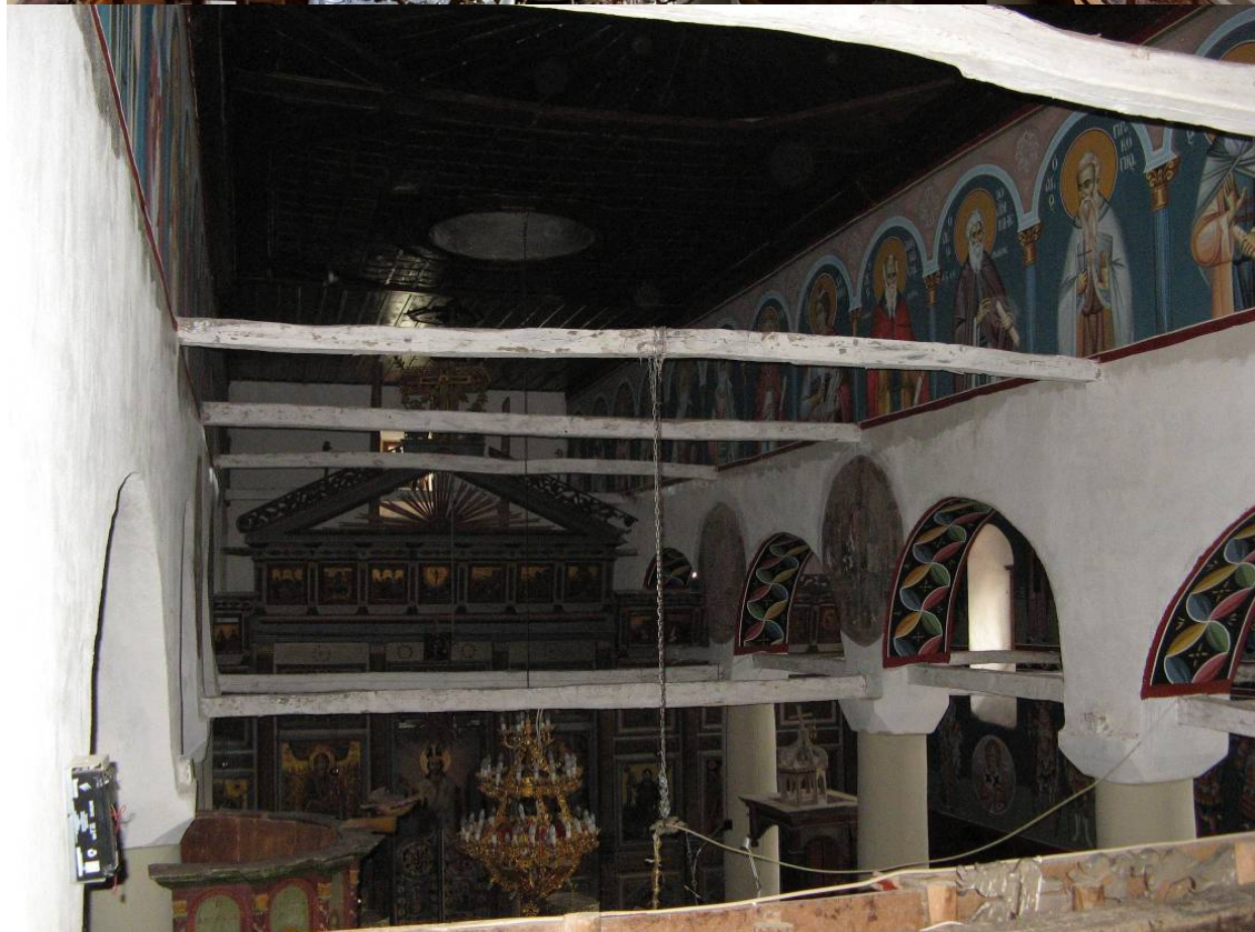
Ε.16.01, Ε.16.02. Αφαίρεση ελκυστήρων
