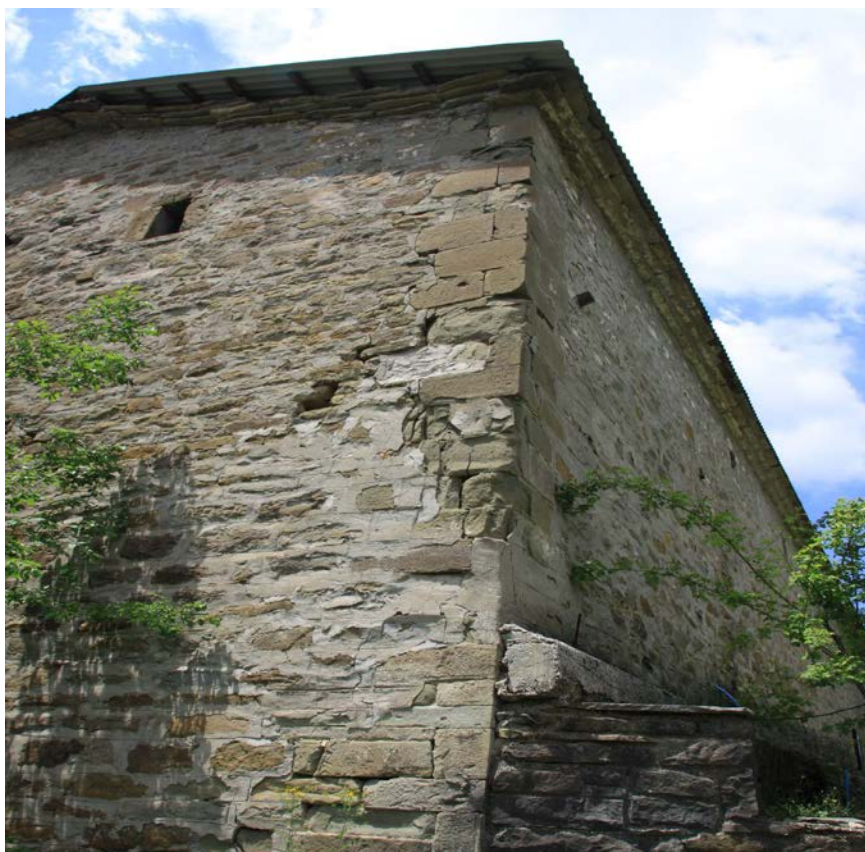
Ε.16.04. Αποκόλληση λίθων στη βορειοανατολική γωνία
