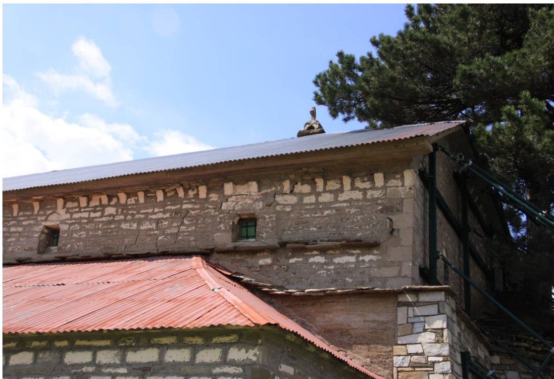
Ε.09.03. Τοιχείο οπλισμένου σκυροδέματος που εφάπτεται στην εξωτερική πλευρά του ανατολικού τοίχου
