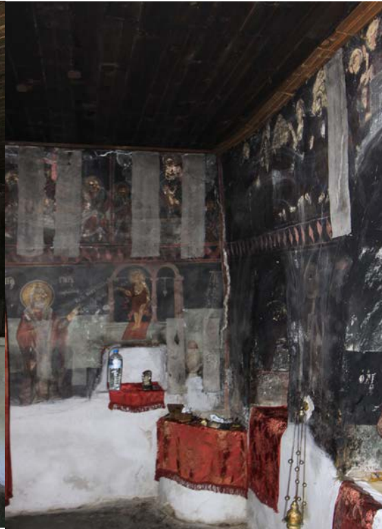
Ε.29.05. Ρηγματώσεις στο Ιερό
