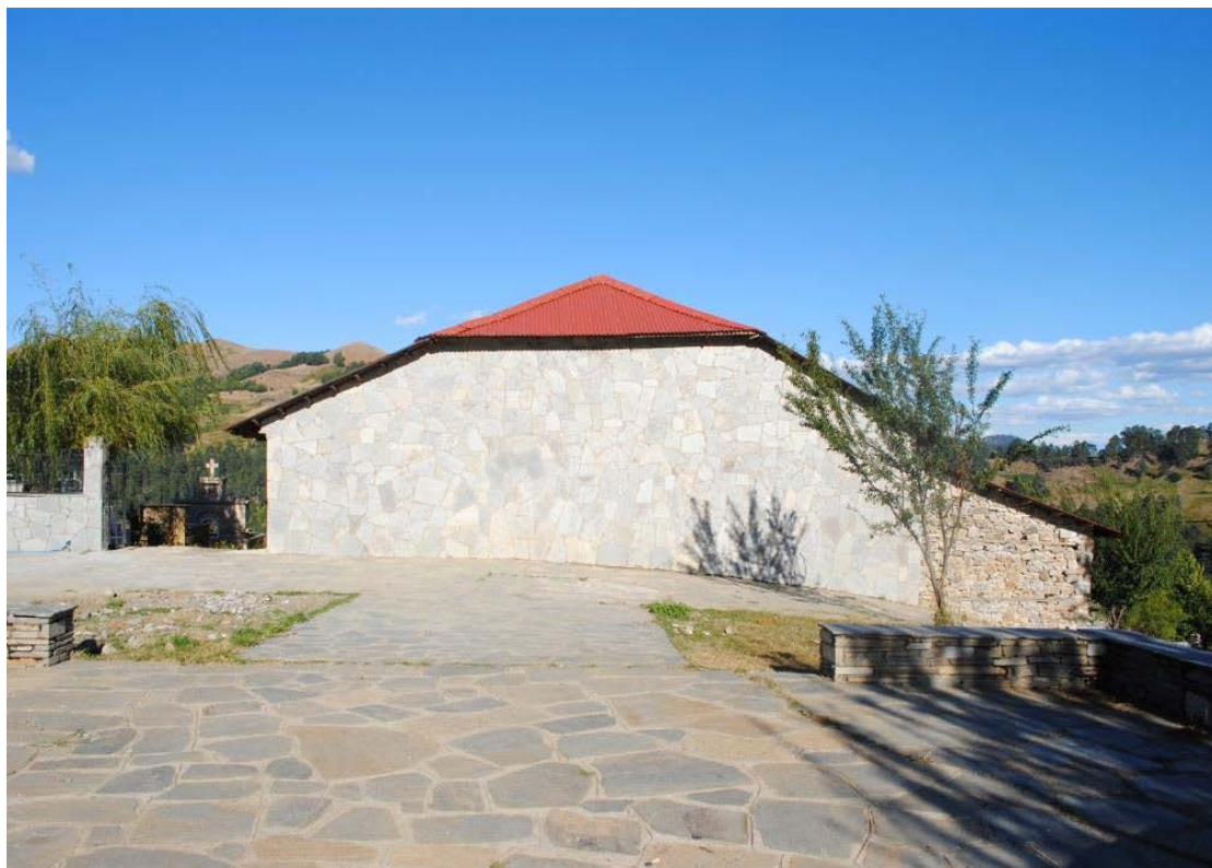
Ε.20.04. Επένδυση με πλάκες της δυτικής πλευράς
