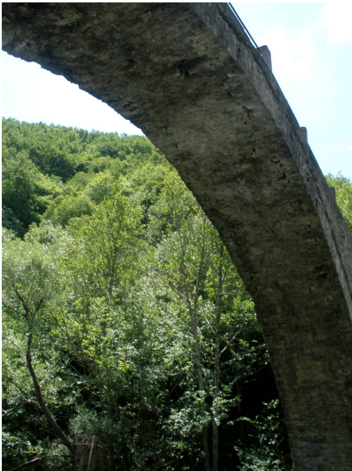
Γ.02.08. Ρηγμάτωση και απώλεια λίθων μεσορράχειου
