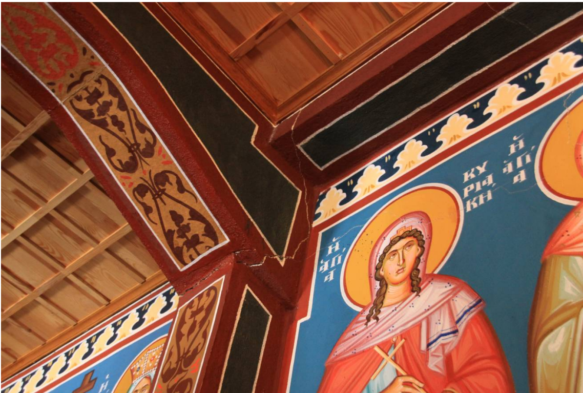
Ε.19.09. Ρηγματώσεις στους κόμβους των πλαισίων Ο/Σ
