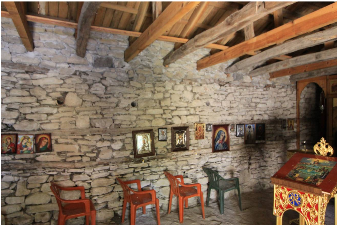
Ε.21.04. Πλήρης απόπλυση συνδετικού κονιάματος περιμετρικών τοίχων
