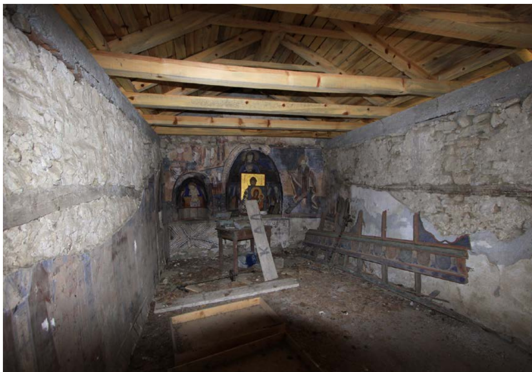
Ε.28.03. Εσωτερική όψη προς το Ιερό
