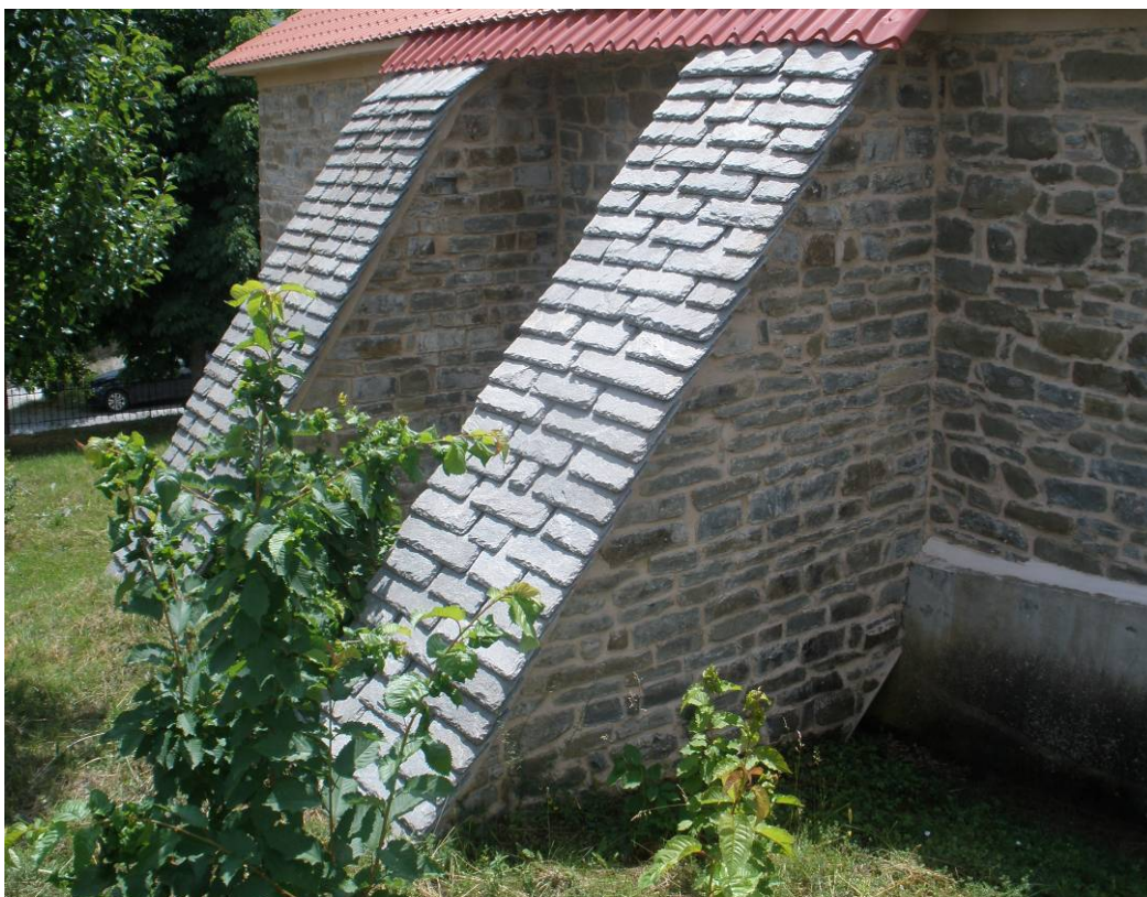
Ε.15.01. Πυραμοειδείς αντηρήδες βαρύτητας στο βόρειο τοίχο
