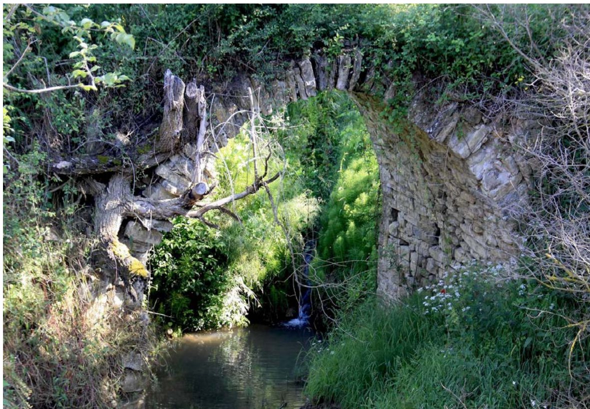
Γ.06.02. Γενική ΝΑ άποψη – ριζικά στο τόξο, έντονη βλάστηση στο λιθόσωμα
