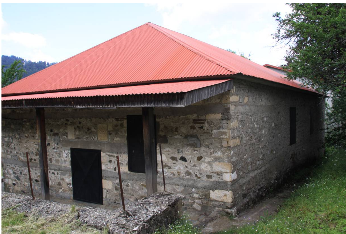
Ε.11.06. Μεταγενέστερη κατασκευή υποστέγων
