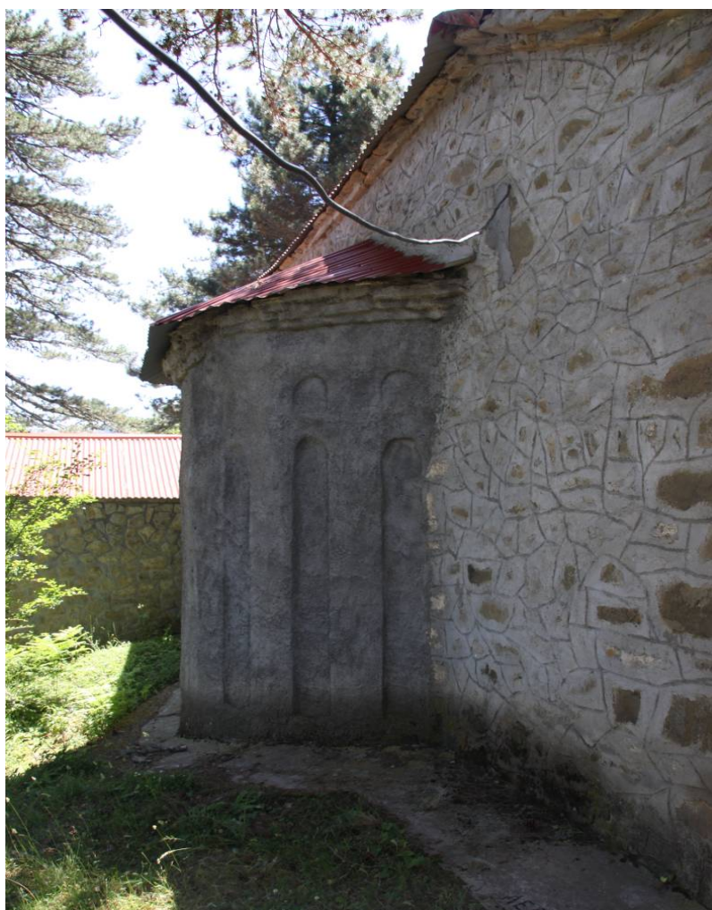
Ε.17.01. Επένδυση κόγχης ιερού με τσιμεντοειδές επίχρισμα
