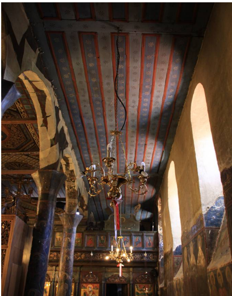
Ε.06.06. Προσωρινή στήριξη τοιχογραφιών και αποκατεστημένη οροφή
