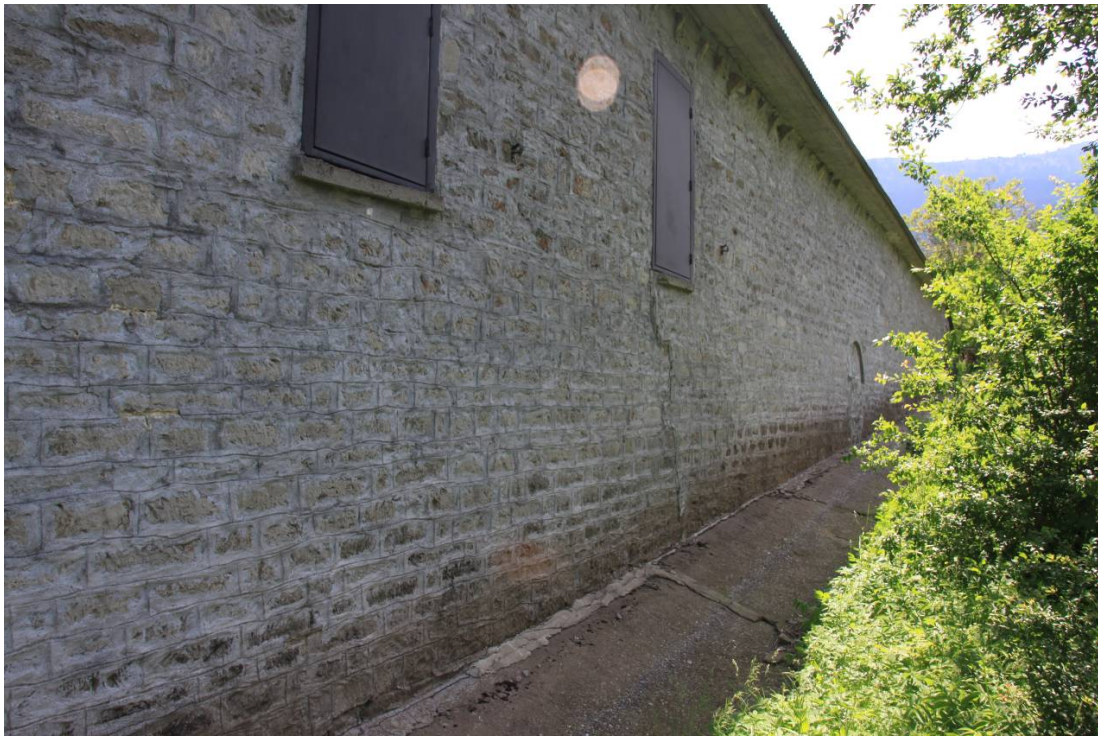
Ε.09.06. Σεναζ οπλισμένου σκυροδέματος
