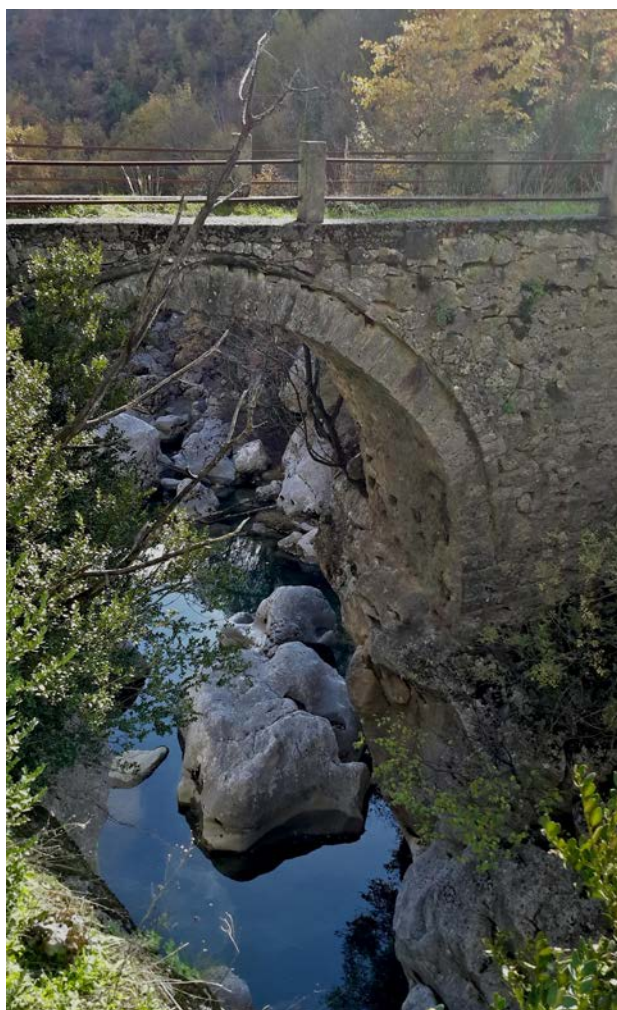
Γ.01.02. Γενική άποψη γεφυριού(κατάντι)
