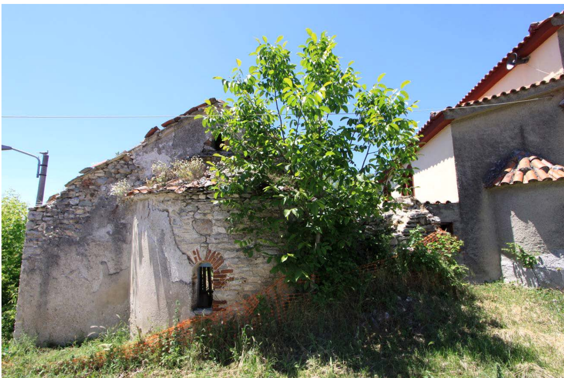
Ε.23.01. Σωζόμενος ανατολικός τοίχος ναού
