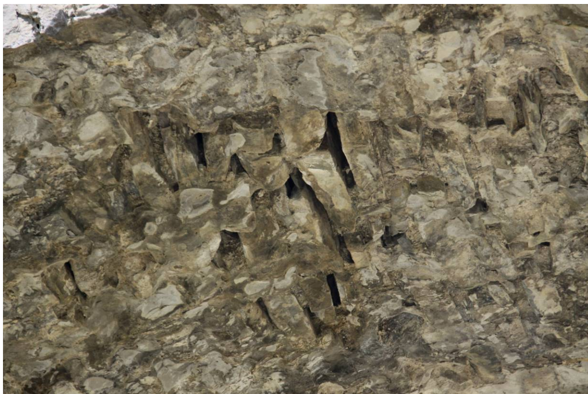
Γ.02.05. Απώλεια λιθοσωμάτων στο μεσορράχιο
