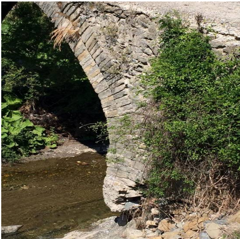
Γ.07.05. Υποσκαφή δυτικού ακροβάθρου
