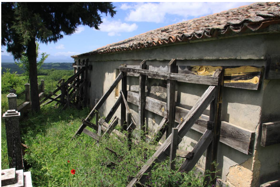
Ε.03.03. Προσωρινές αντιστηρίξεις στο νότιο τοίχο
