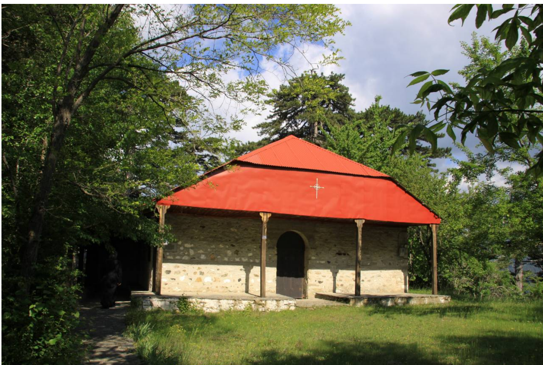
Ε.12.05. Γενική άποψη του ναού – λαμαρίνα στη στέγη
