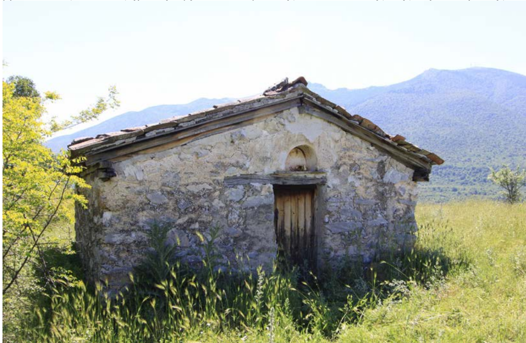
Ε.26.01. Είσοδος ναού, δυτική όψη
