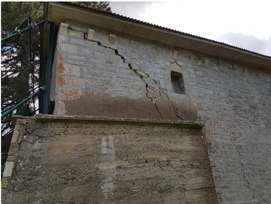
Ε.09.02. Τοιχείο οπλισμένου σκυροδέματος που εφάπτεται στην εξωτερική πλευρά του ανατολικού τοίχου
