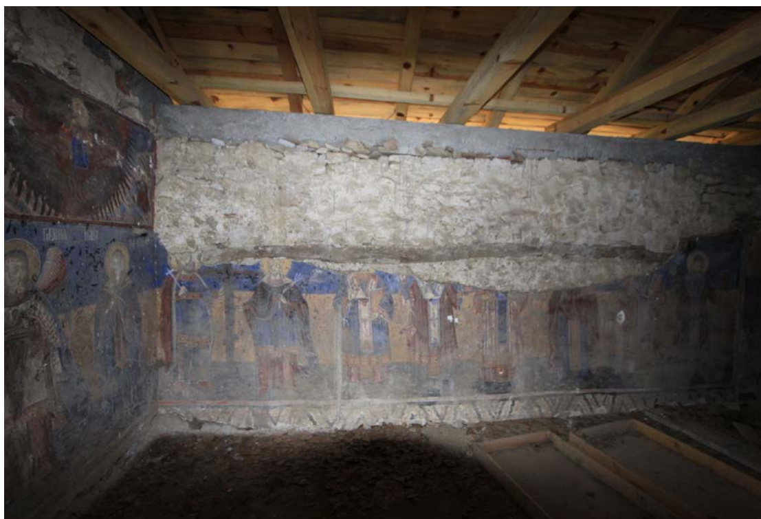
Ε.28.04. Εσωτερική όψη αγιογραφιών με νέα στέγη και σενάζ έδρασης της
