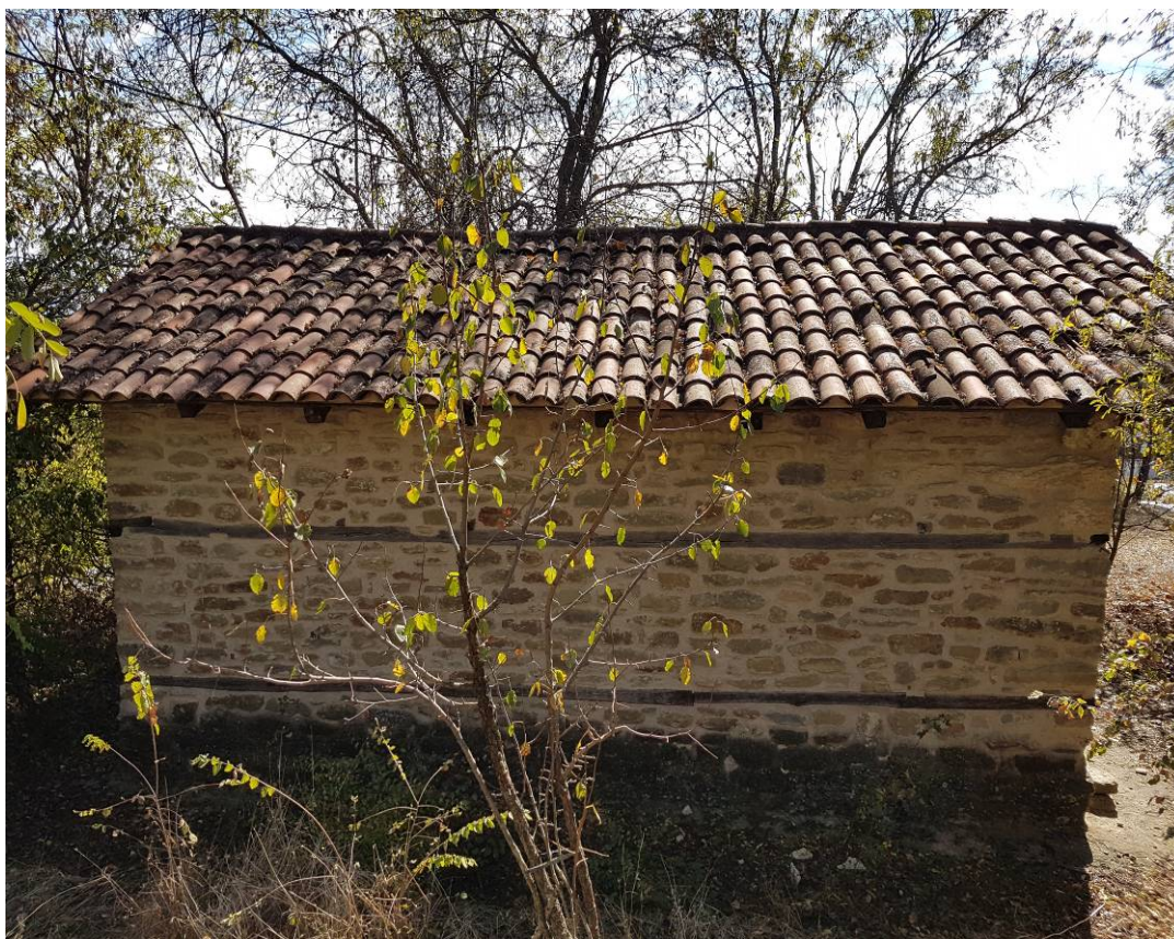
Ε.04.02. Βόρειος τοίχος και στέγη ναού
