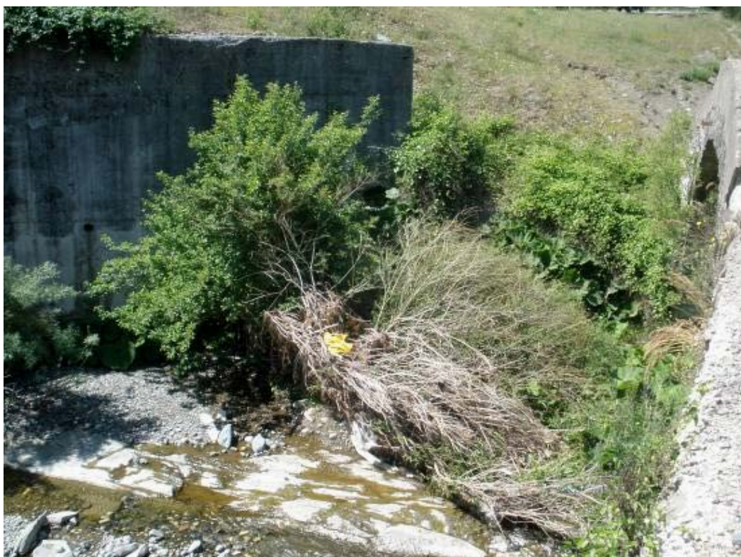
Γ.07.03. Ανάπτυξη δένδρων πλησίον πλαγιοπτερυγότοιχου νεώτερης γέφυρας
