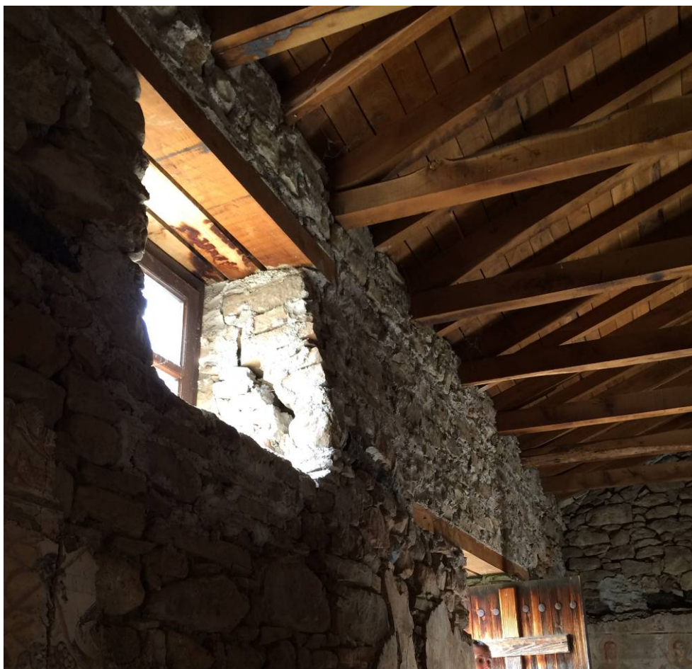
Ε.08.05. Ρηγμάτωση στη νότια τοιχοποιία
