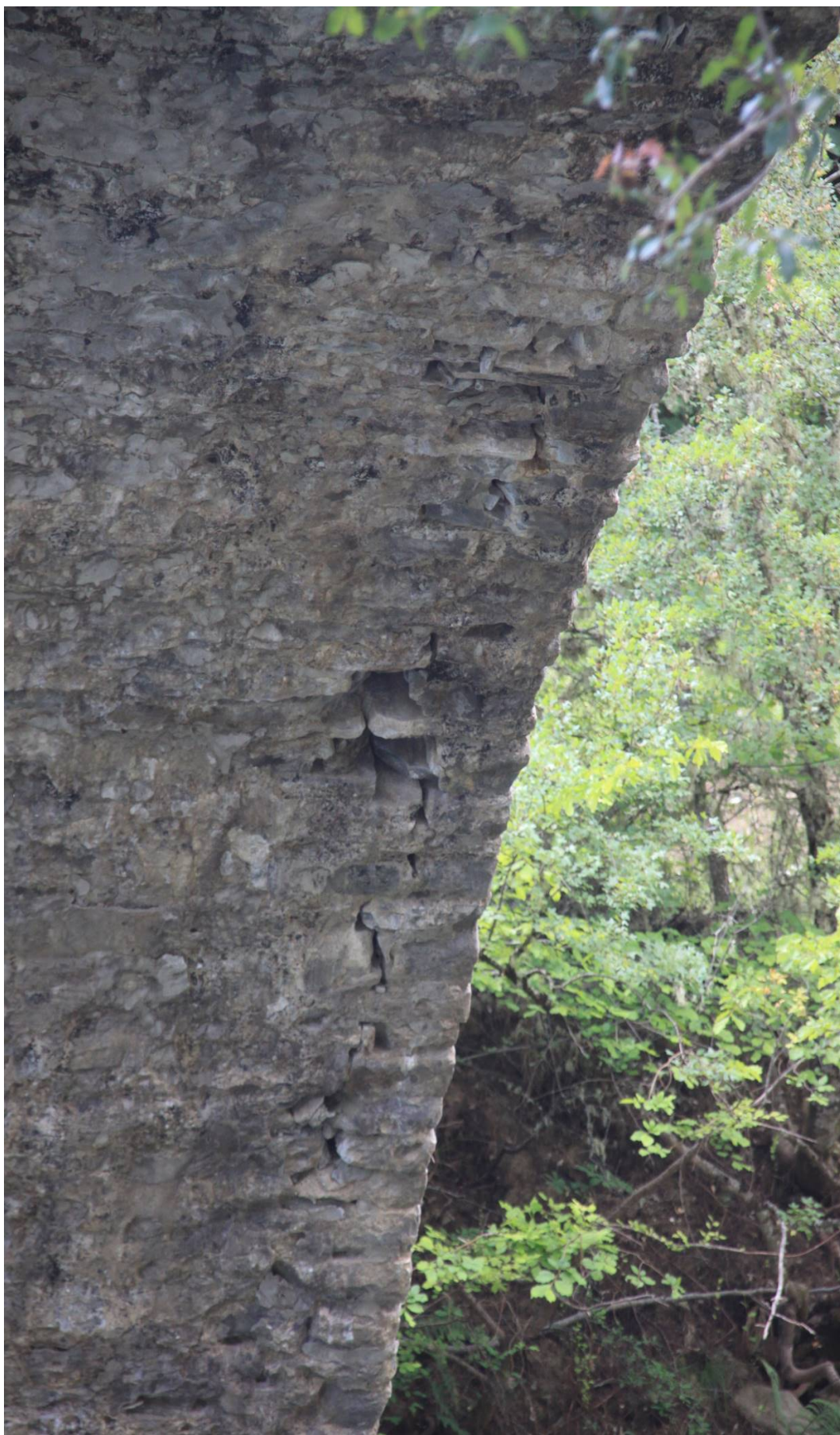
Γ.02.07. Ρηγμάτωση μεσοράχειου
