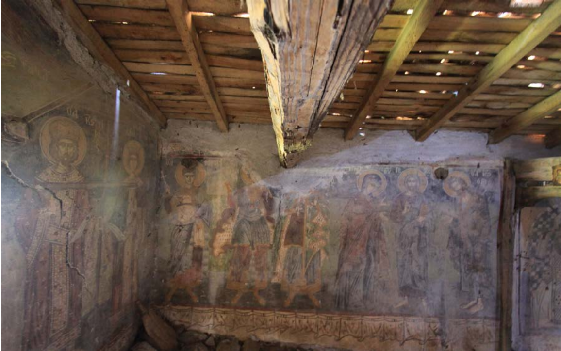
Ε.26.04. Αγιογραφίες και σενάζ στέγης με μείωση ύψους επιστέγασης
