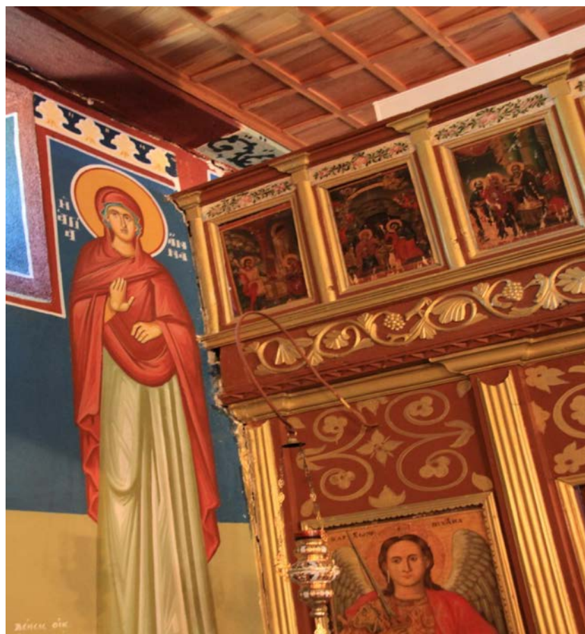
Ε.19.08. Κατακόρυφη ρωγή στο βόρειο τοίχο στη θέση συναρμογής του τέμπλου του ιερού
