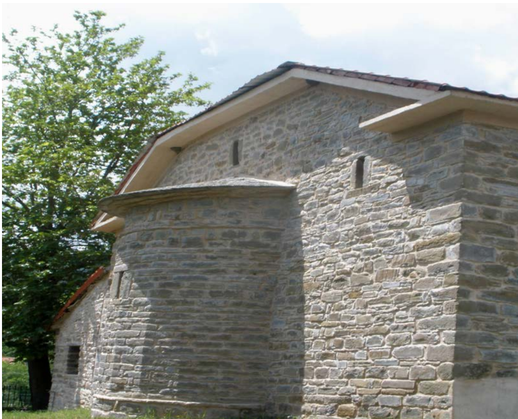
Ε.15.05. Κατασκευή σενάζ στη στέψη των λιθοδομών
