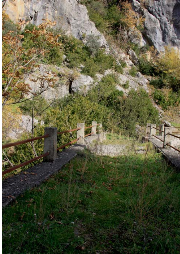
Γ.01.04. Κατάστρωμα με πυκνή βλάστηση
