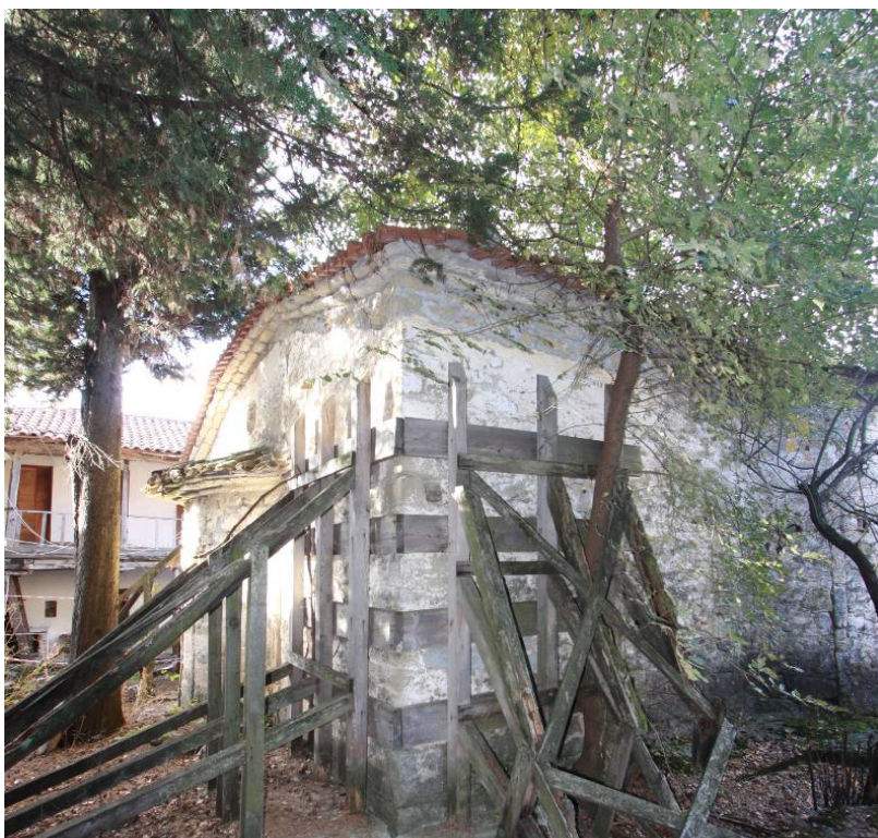
Ε.01.05. Οριζόντια υποστήλωση βορειοανατολικής γωνίας
