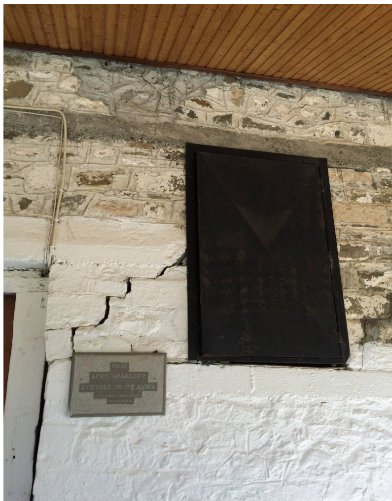
Ε.11.02. Διαγώνιες ρηγματώσεις στα ανοίγματα
