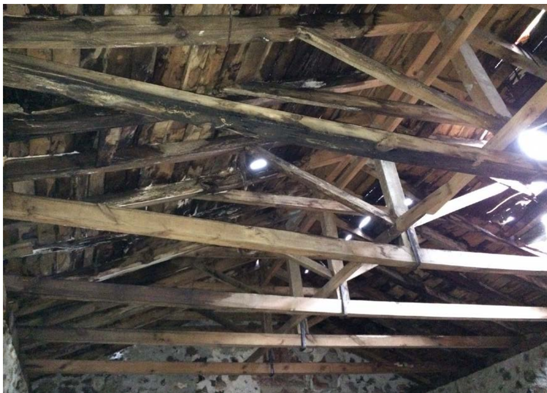
Ε.30.03. Γενική άποψη της στέγης εσωτερικά
