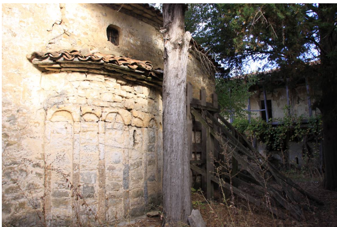
Ε.01.04. Οριζόντια υποστύλωση ανατολικού τοίχου
