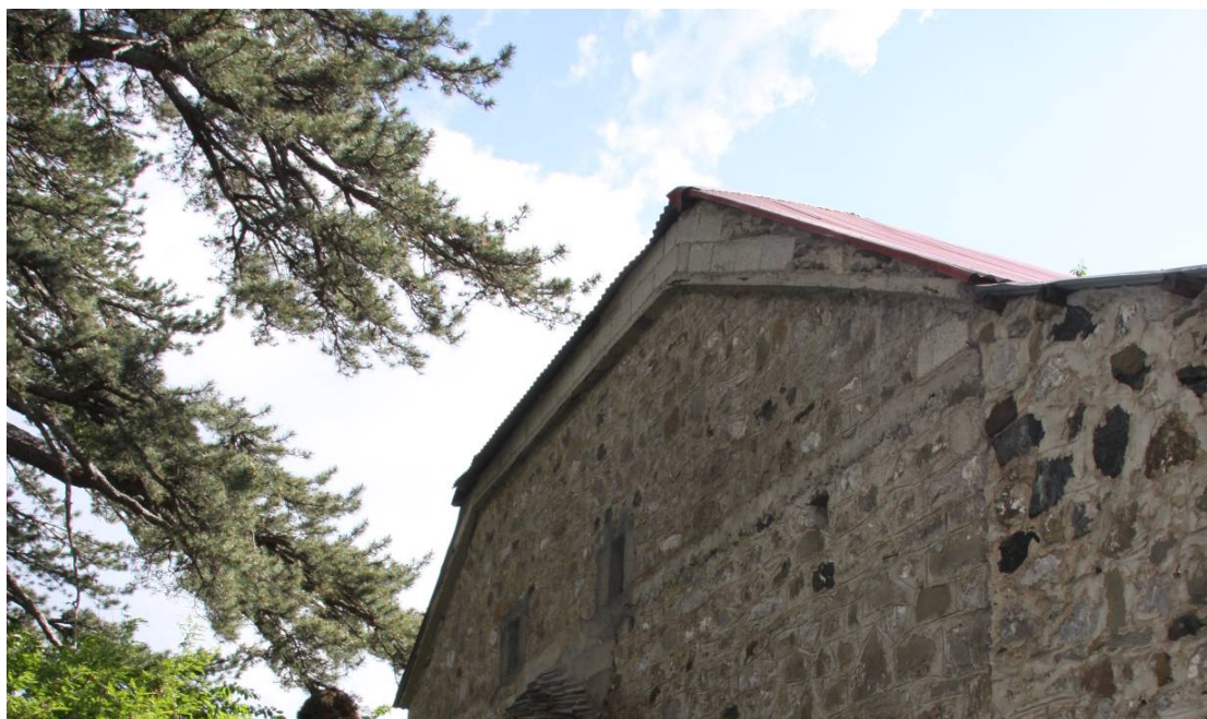
Ε.12.02. Γείσο από τσιμεντόλιθους και οπλισμένο σκυρόδεμα
