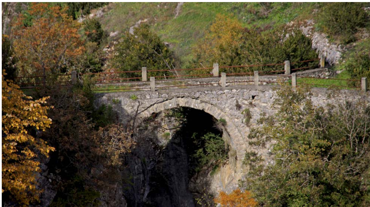
Γ.01.01. Γενική άποψη του γεφυριού από απόσταση (ανάντι)
