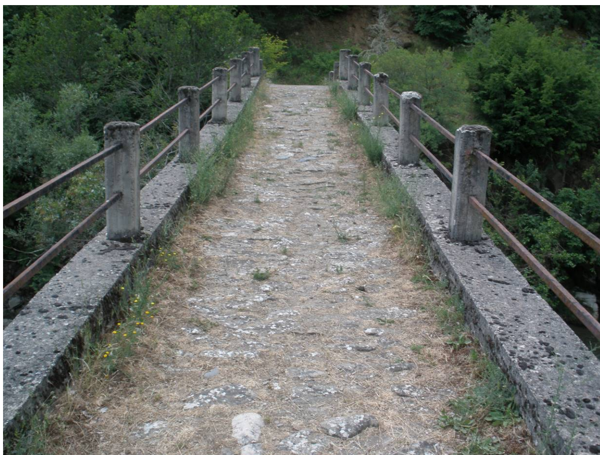
Γ.02.06. Αποψη καταστρώματος
