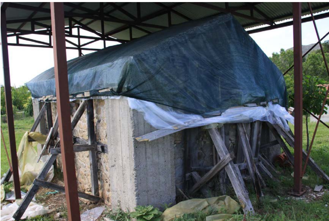
Ε.02.02. Νοτιοανατολική όψη ναού. Προσωρινές αντιστηρίξεις και τοιχία στις γωνίες
