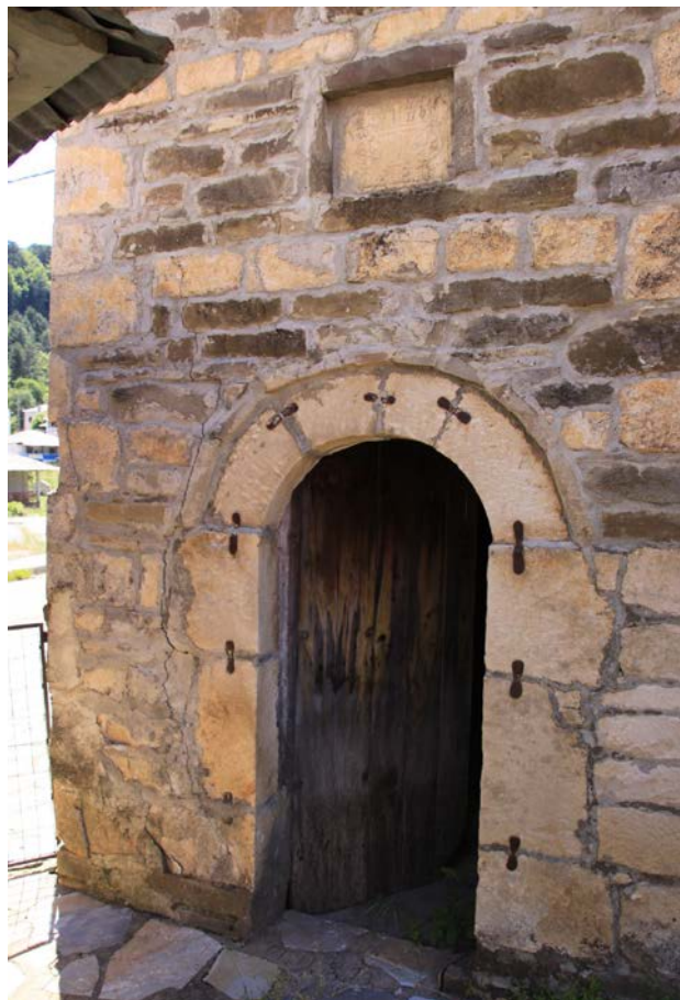
Ε.18.11. Μικρορηγματώσεις στο κωδωνοστάσιο
