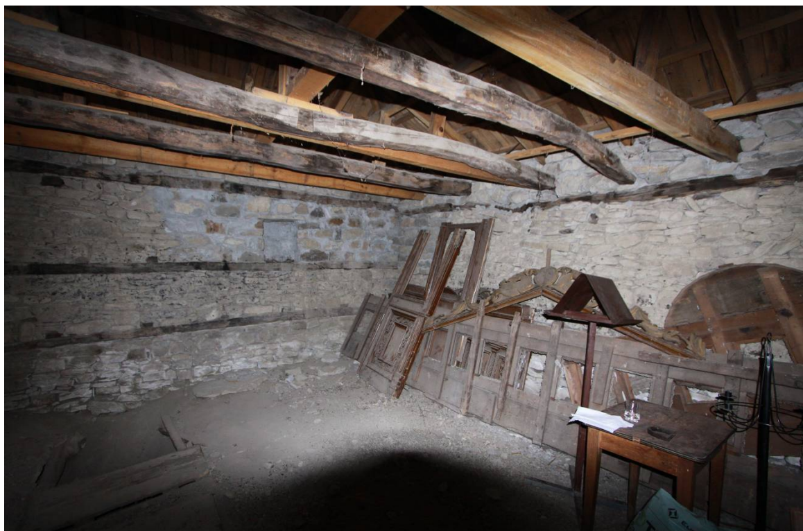
Ε.21.08. Δάπεδο υπερυψωμένου χώρου
