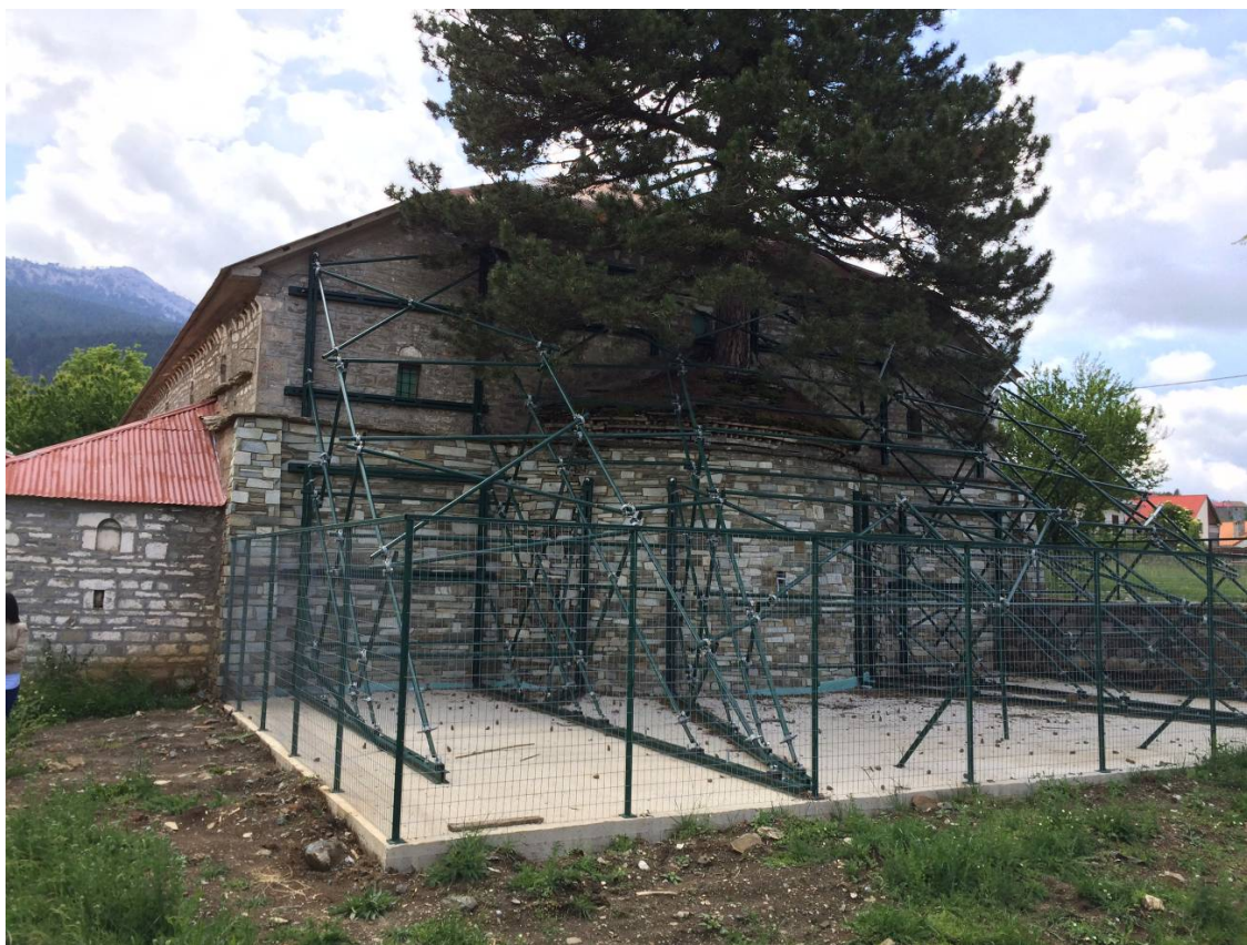
Ε.09.04. Μεταλλικό χωροδικτύωμα
