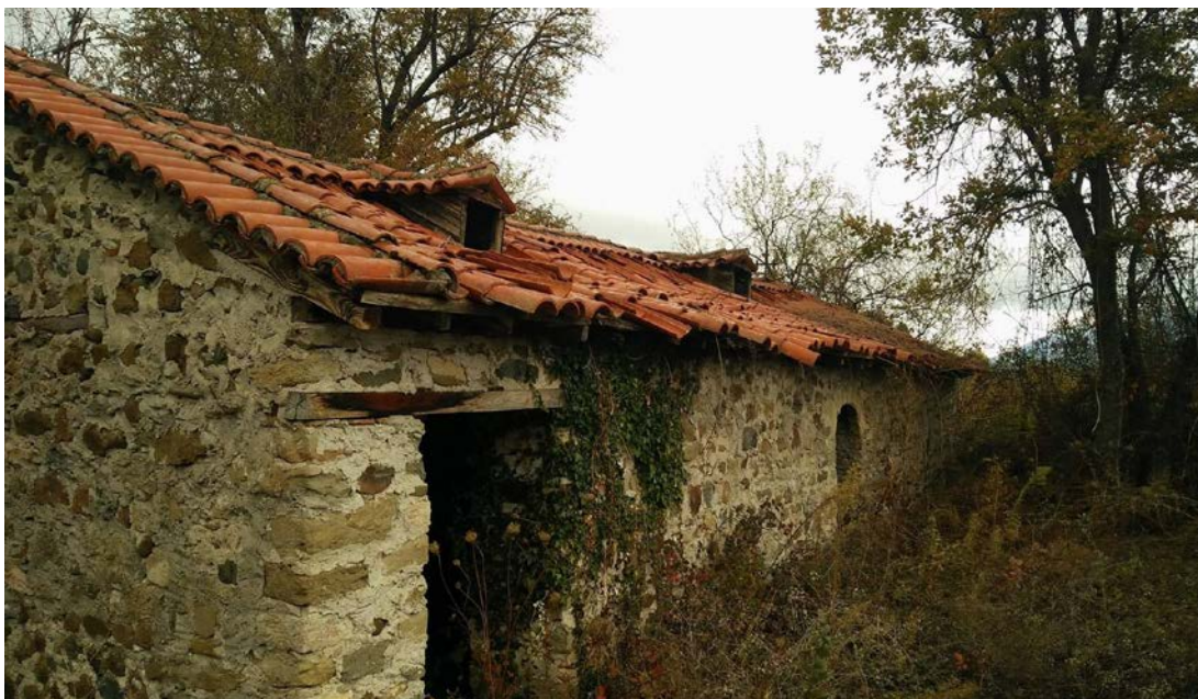
Ε.30.09. Εξωτερική όψη με φεγγίτες
