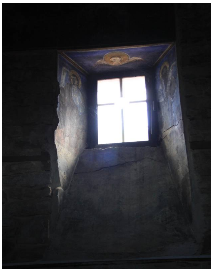
E.07.03. Οριζόντιά ρωγμή σε ποδιά παραθύρου
