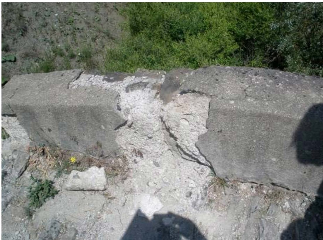
Γ.07.08. Στηθαία καταστρώματος γεφυριού
