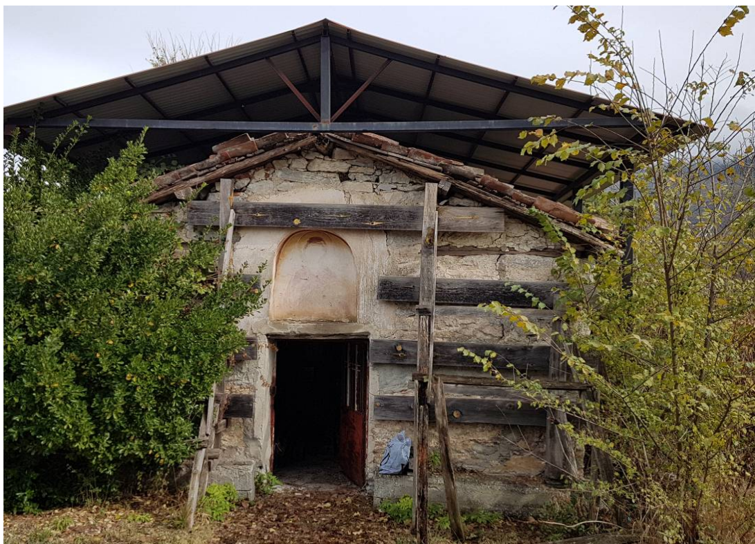
Ε.25.02. Μεταλλικό προστατευτικό στέγαστρο
