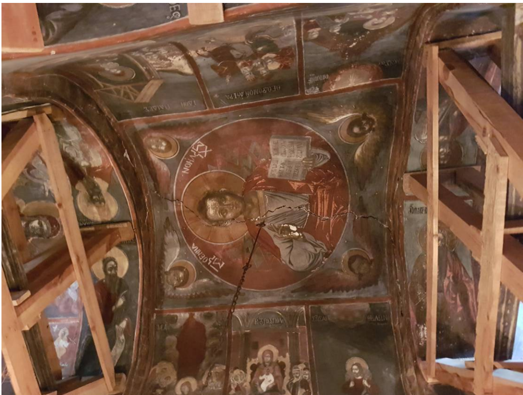
Ε.01.12. Ρωγμές στο θόλο του κεντρικού κλίτους
