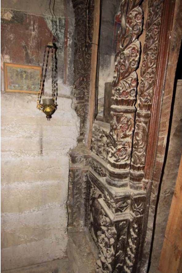
Ε.31.05. Εσωτερικός μανδύας στη Β πλευρά
