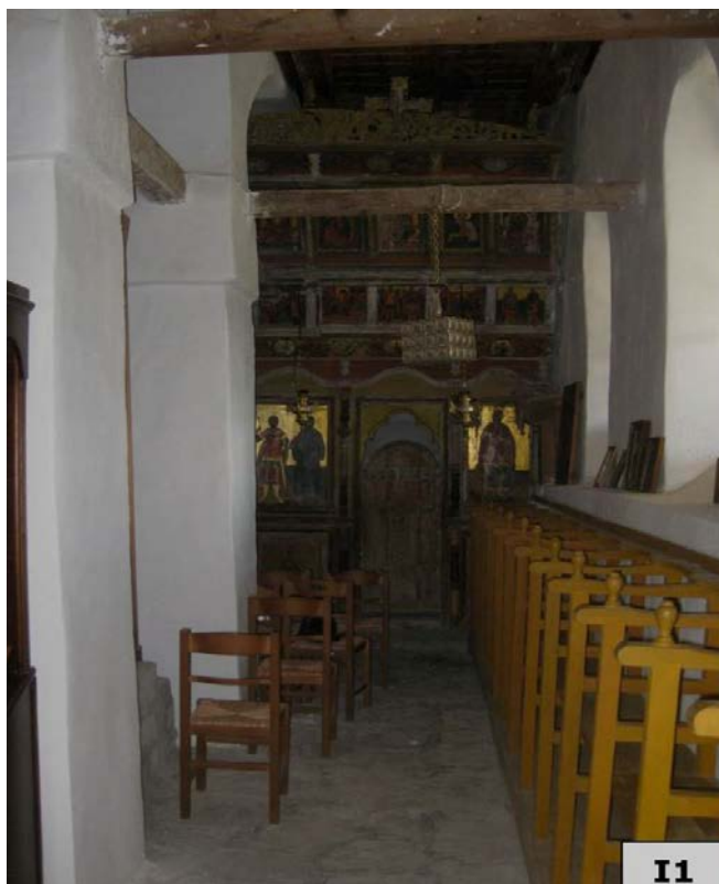
E.20.03. Επένδυση λίθινων υποστυλωμάτων με σκυρόδεμα
