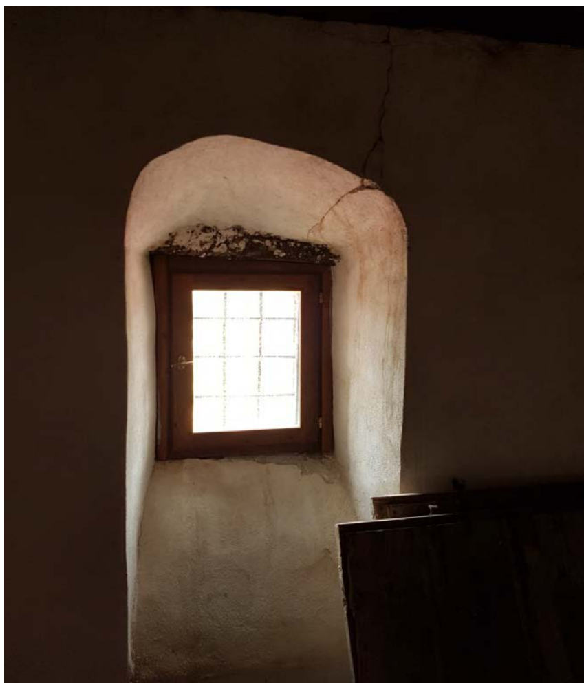
Ε.16.03. Ρηγμάτωση σε υπέρθυρο
