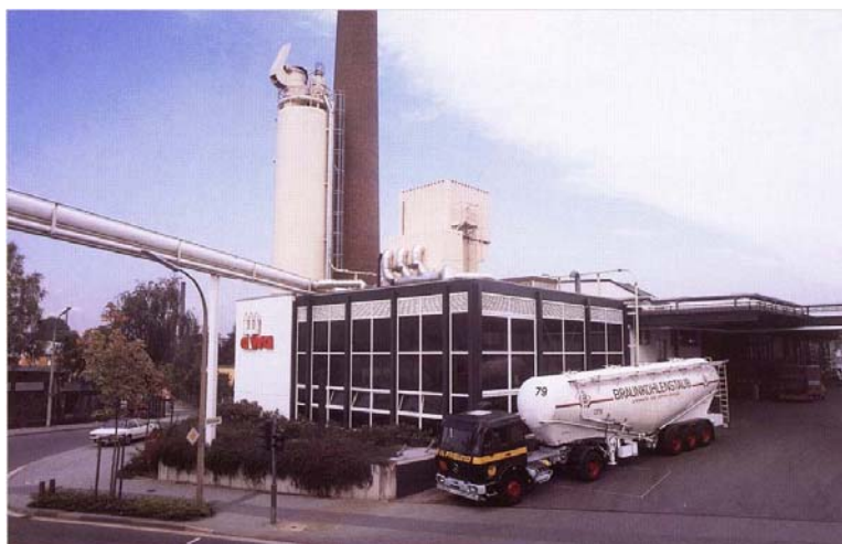
Εικόνα 1: Τροφοδοσία μονάδας θερμικής ισχύος 7 MW με ξηρό λιγνίτη, σε αστικό περιβάλλον
