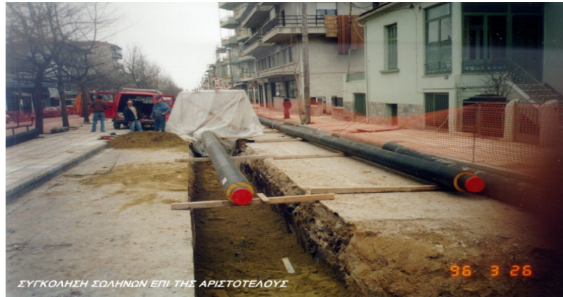
Εικόνα 2: Κατασκευή του δικτύου διανομής θερμικής ενέργειας της εγκατάστασης τηλεθέρμανσης Κοζάνης
