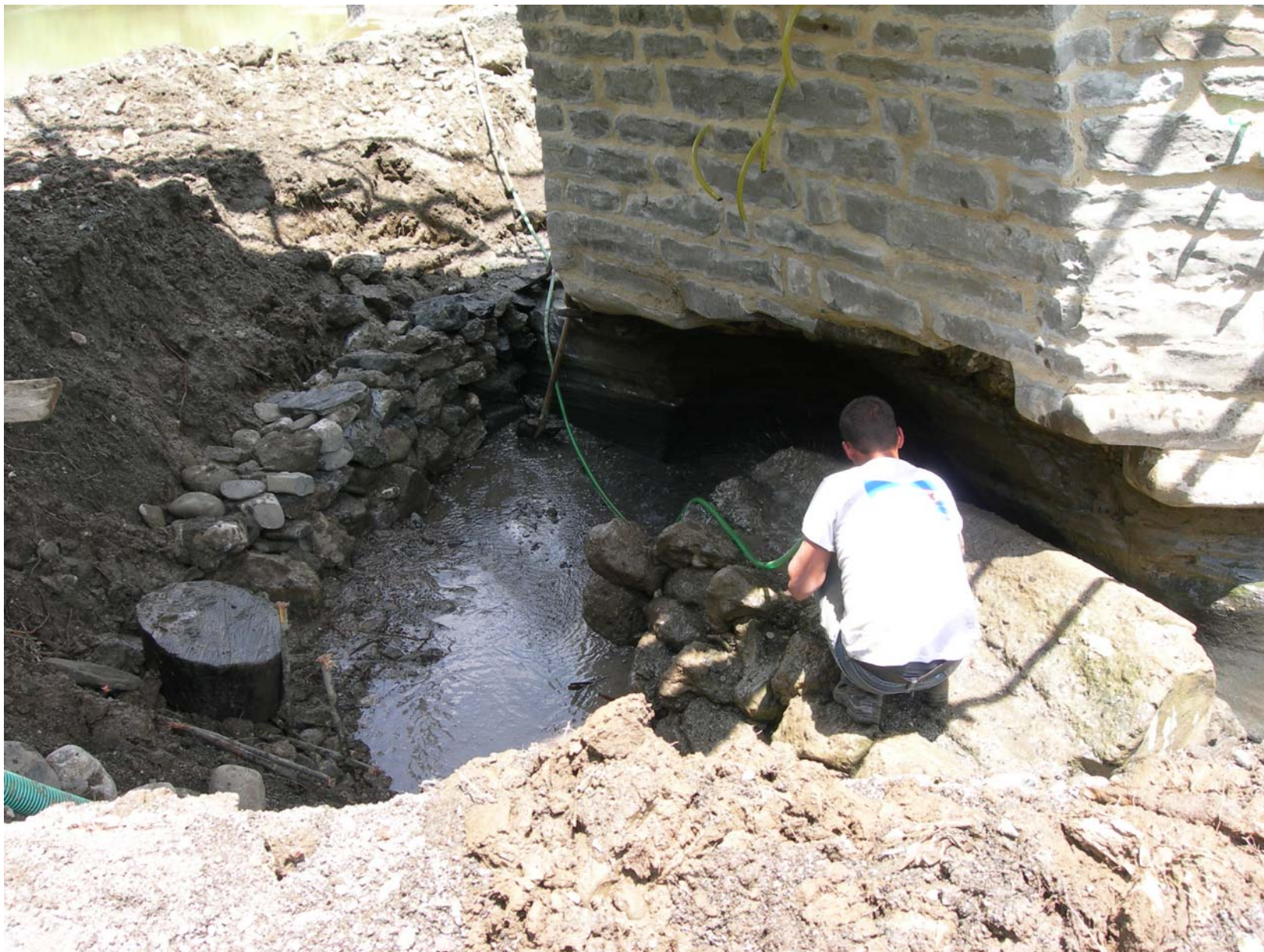
ΕΡΓΟ : ΑΠΟΚΑΤΑΣΤΑΣΗ ΠΕΤΡΟΓΕΦΥΡΟΥ ΖΙΑΚΑ – ΥΠΟΣΚΑΦΗ ΜΕΣΟΒΑΘΡΟΥ ΚΑΘ’ ΥΨΟΣ ΜΕΜΟΝΩΜΕΝΗΣ ΚΑΤΑΚΟΡΥΦΗΣ ΔΙΑΚΛΑΣΗΣ ΒΡΑΧΟΥ
